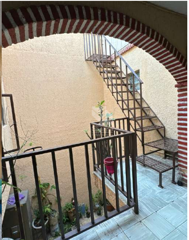
Escaleras a tercer nivel
