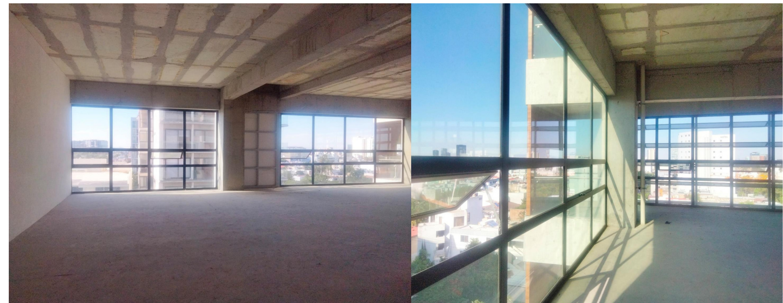
Ej. Obra gris
