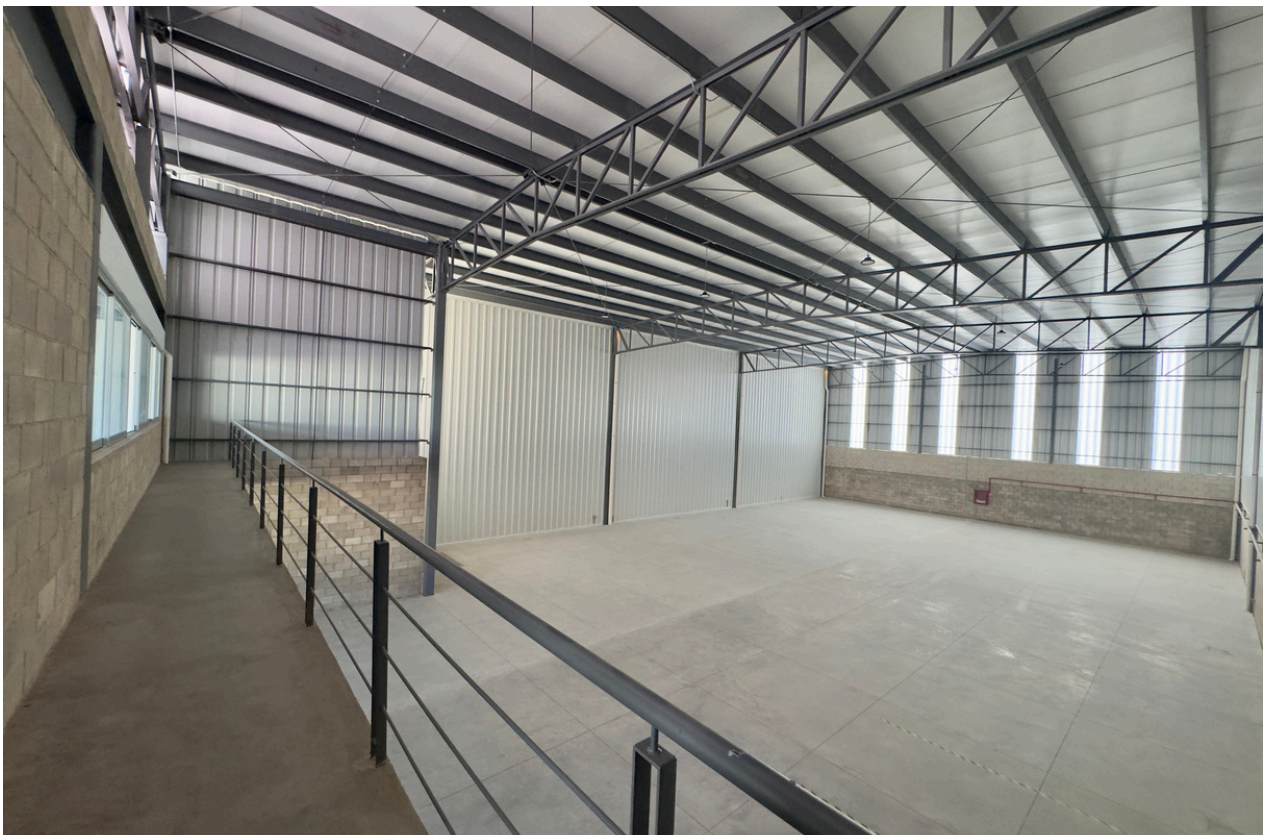
VISTA DE ALMACEN DESDE SEGUNDO PISO
