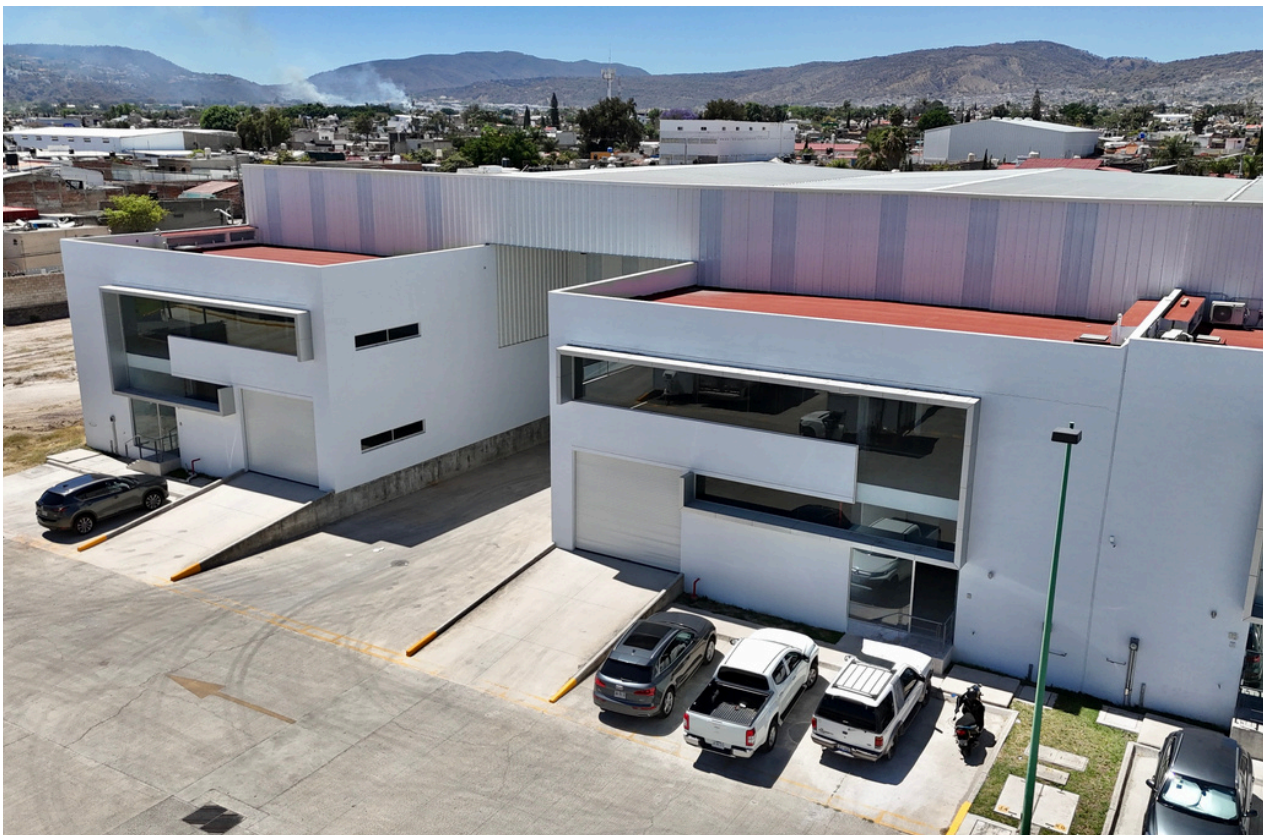
FACHADA DE BODEGAS
