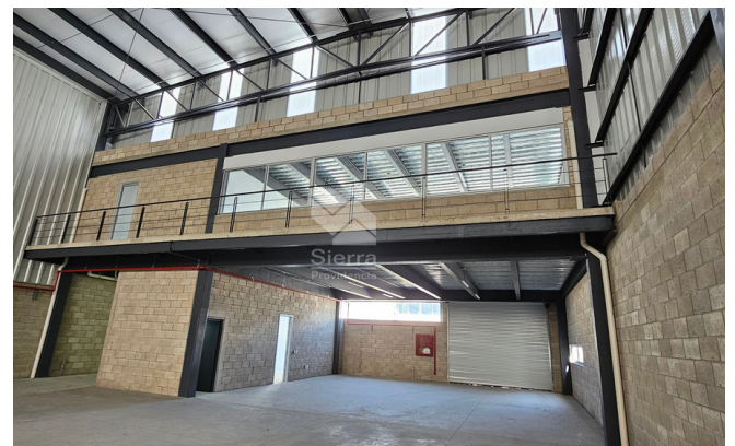
BODEGA EN CONSTRUCCIÓN
