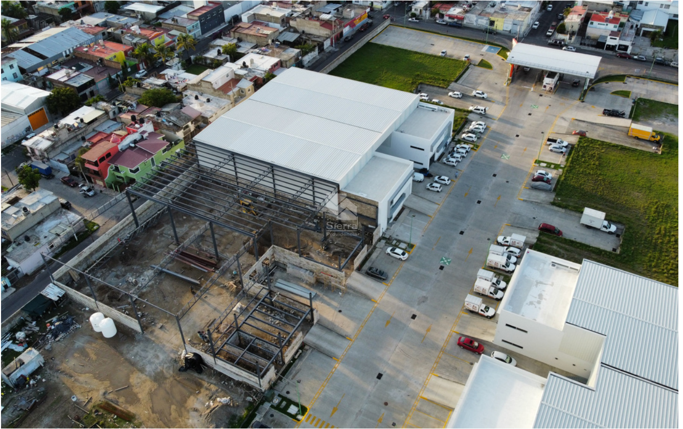
BODEGA EN CONSTRUCCIÓN
