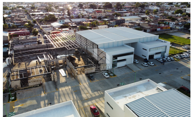
BODEGA EN CONSTRUCCIÓN
