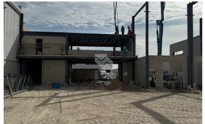
ESTRUCTURA DE BODEGA
