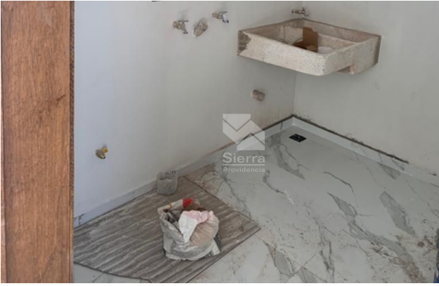
Cuarto de Lavado
