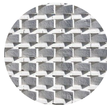
MURO DIVISORIO: MURO CALADO
