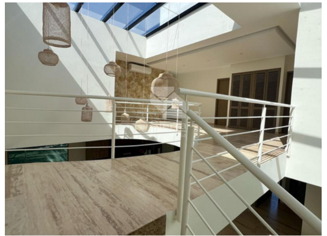
Techo doble altura
