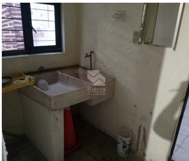
Cuarto de lavado
