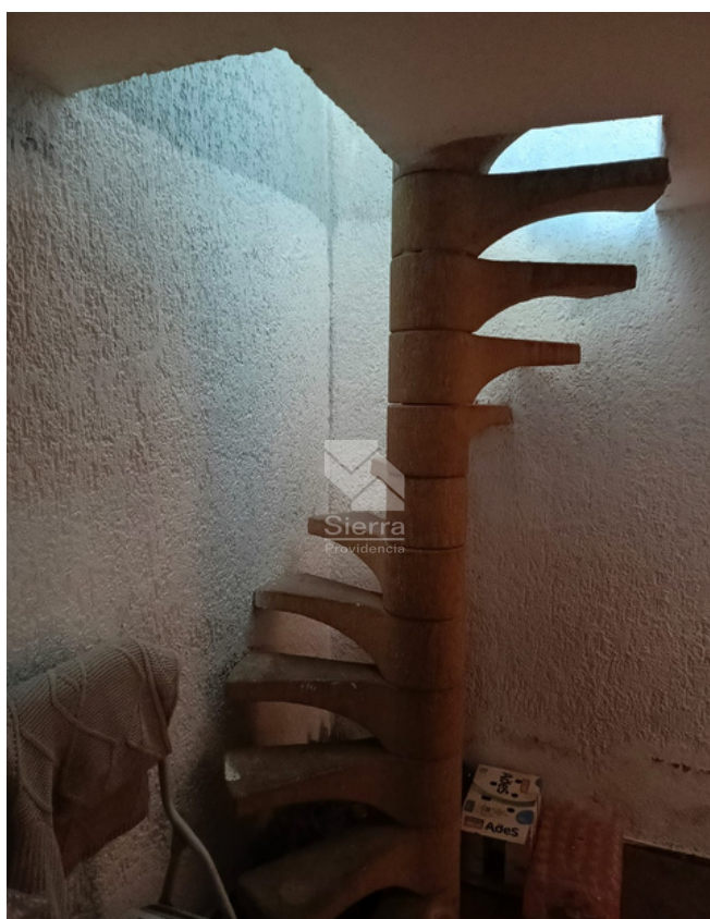
ESCALERAS DE SERVICIO
