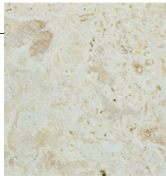
Muros exteriores Coralina
