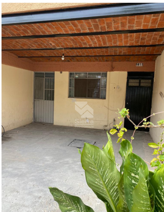
INGRESO A CASA Y DEPARTAMENTOS PB
