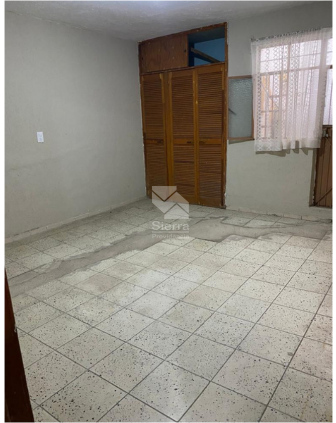
RECÁMARA DE CASA HABITACIÓN
