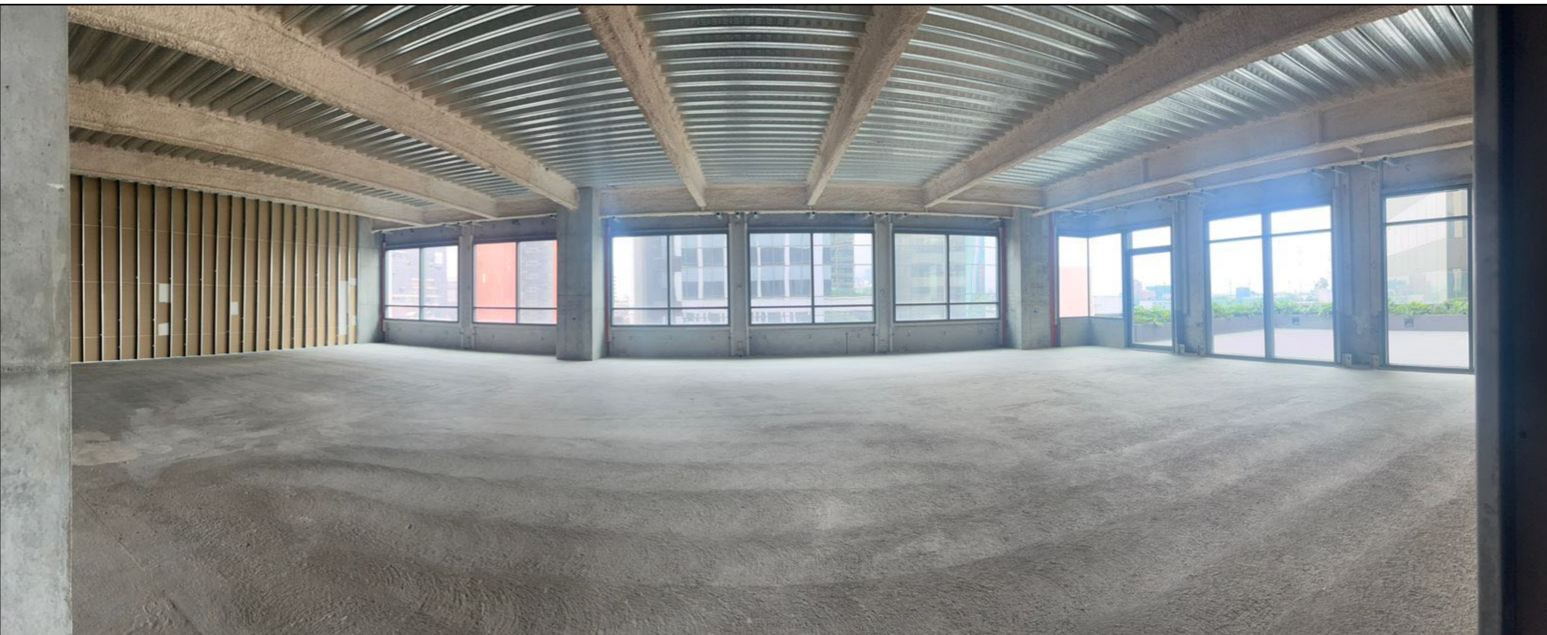
Vista general interior / Terraza del lado derecho
