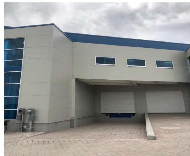
Rampa niveladora de 15,000 libras y andén para trailer, luminarias LED, piso de concreto MR42 de 15cm, techumbre ecotérmica, fibra óptica, altura máxima de 8 metros y cisterna de 12,500 litros, fachada arquitectónica con panel de importación. *El parque cuenta con planta de tratamientos residuales y sanitarios con canales pluviales, amplios patios de maniobras en adocreto de 350kg/cm2. Para industria, almacenaje o distribución.*
