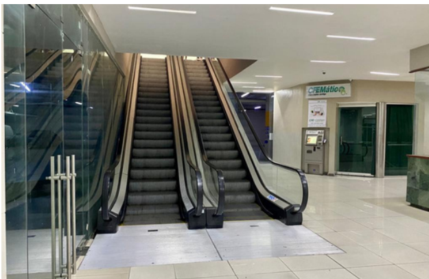
ESCALERAS AL LADO DEL LOCAL
