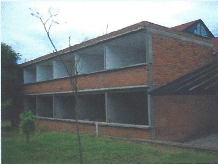
Foto 6. Vista posterior del Edificio Principal.
