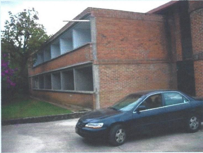
Foto 4. Vista del acceso al Edificio Principal.
