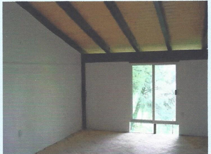
Foto 7. Vista interior de la Casa del Administrador.
