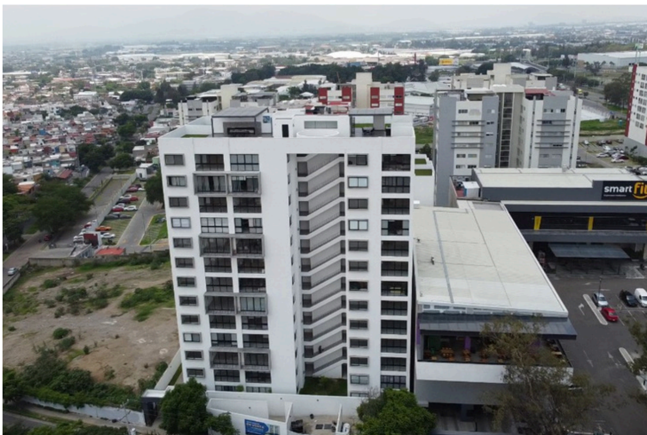
VISTA AÉREA DE LA TORRE
