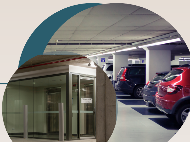
PARQUEO Y ASCENSOR
