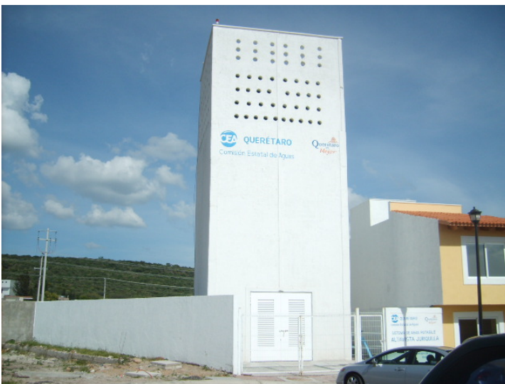
TORRE PROPIA DE AGUA DE 50,000 LTS
