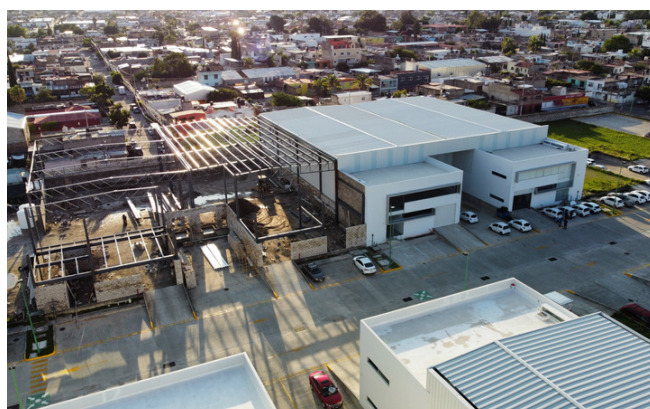
BODEGA EN CONSTRUCCIÓN
