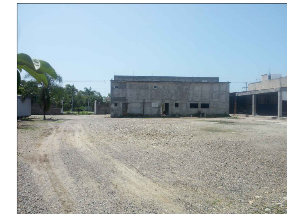
FACHADA POSTERIOR COSTRUCCION
