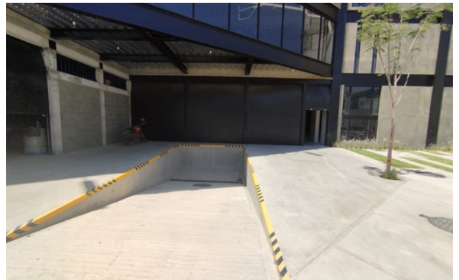
INGRESO PARA DESCARGA
