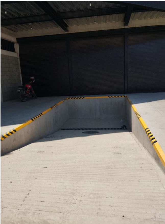
INGRESO PARA DESCARGA
