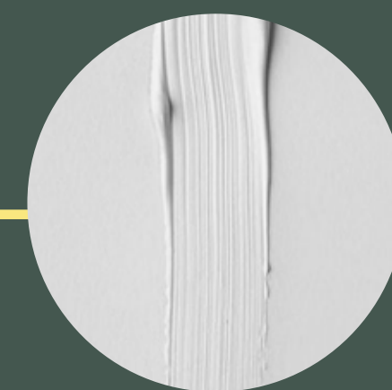
Pintura color perla en fachada.
