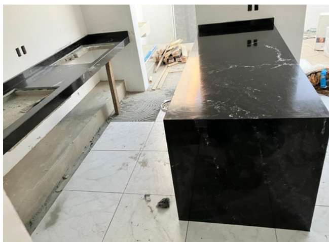
Actualización de obra
