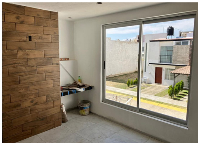
Actualización de obra
