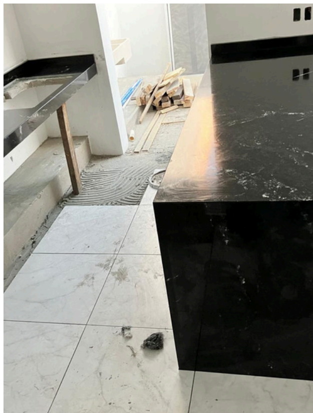
Actualización de obra
