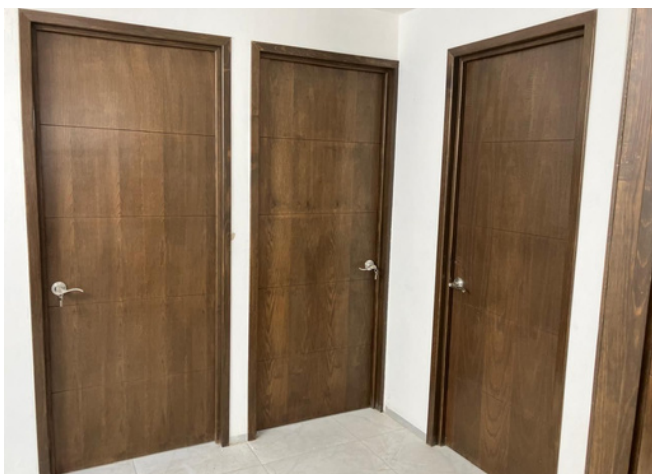
Actualización de obra
