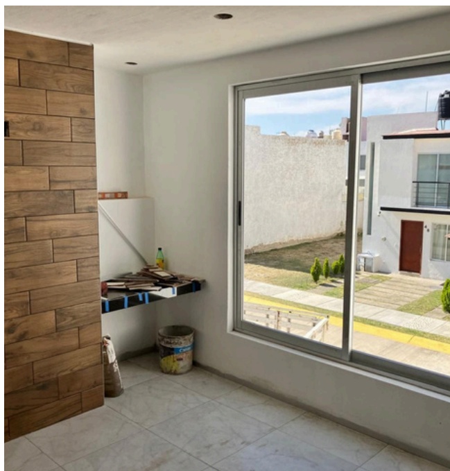
Actualización de obra
