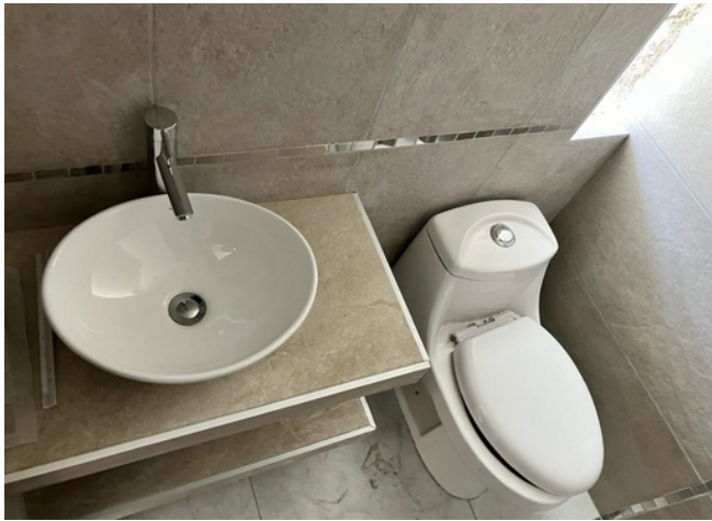
Actualización de obra
