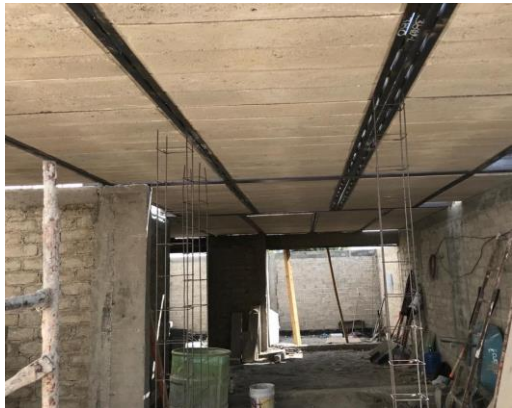
PRIMER AVANCE DE OBRA
