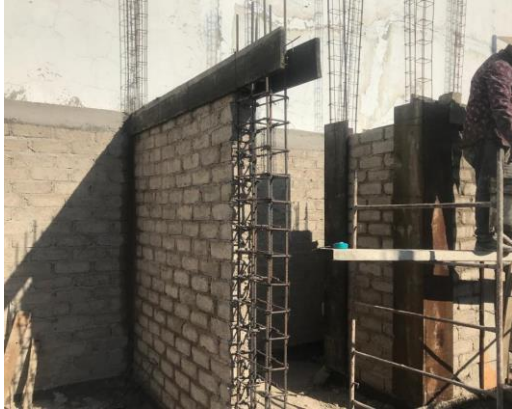
PRIMER AVANCE DE OBRA
