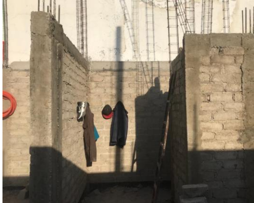
PRIMER AVANCE DE OBRA
