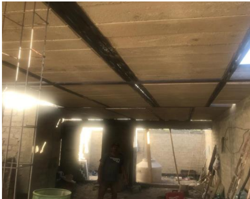
PRIMER AVANCE DE OBRA
