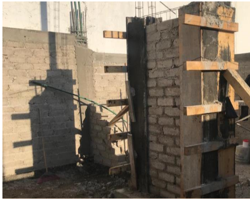
PRIMER AVANCE DE OBRA
