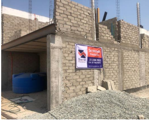
PRIMER AVANCE DE OBRA
