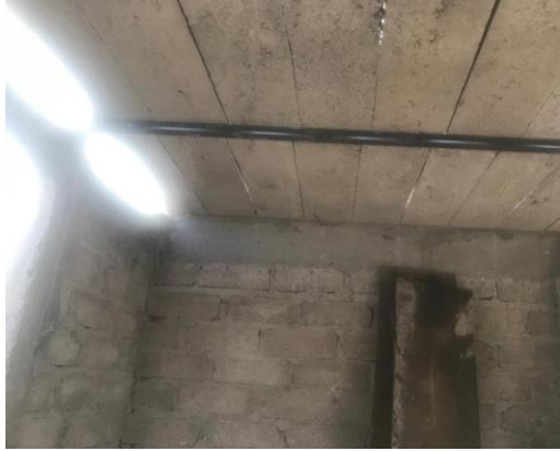
PRIMER AVANCE DE OBRA
