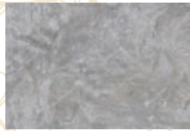
Pisos de concreto pulido de 5 cm
