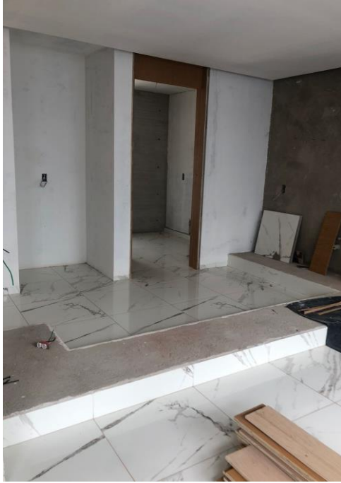
COCINA EN CONSTRUCCIÓN
