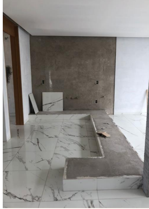
COCINA EN CONSTRUCCIÓN
