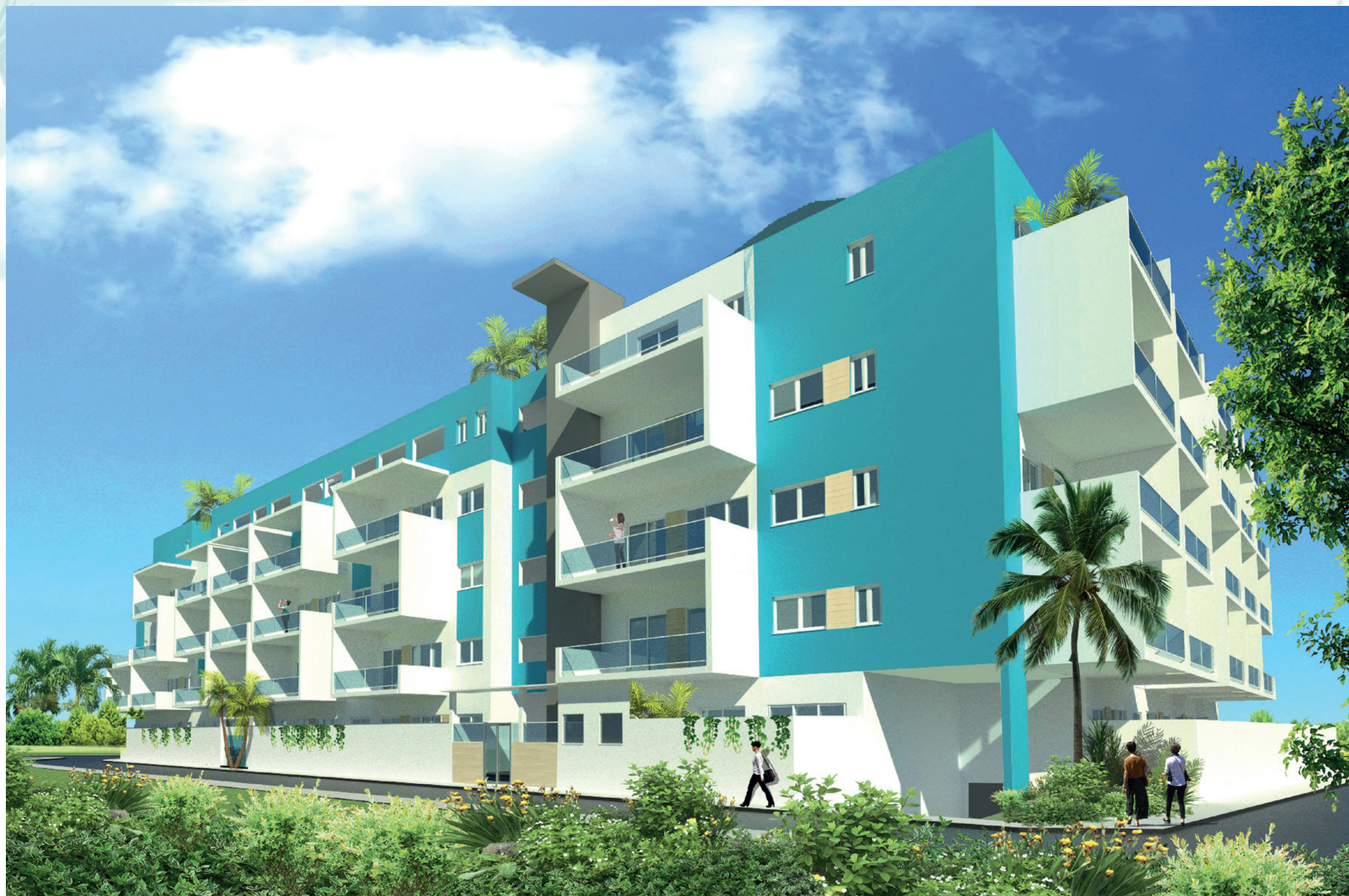
Vista esquina Noroeste
