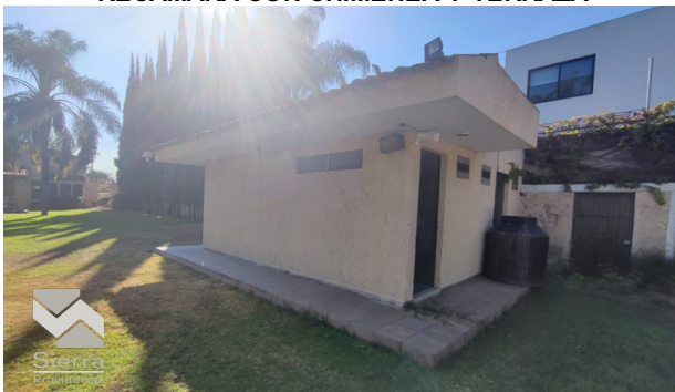
CUARTO DE SERVICIO CON BAÑO COMPLETO
