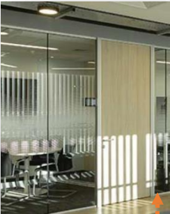
Frentes de vidrio en aluminio. Puerta en madera.
