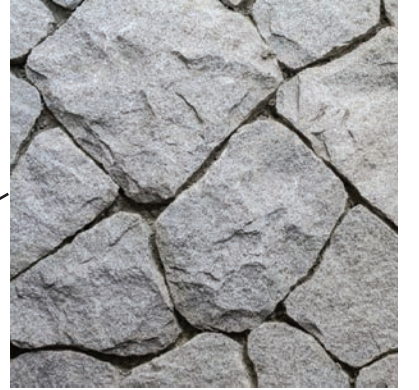
Muro de roca
