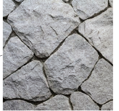
Muro de roca
