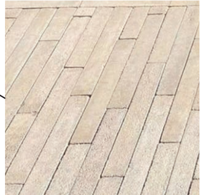
Losetas de barro en piso
