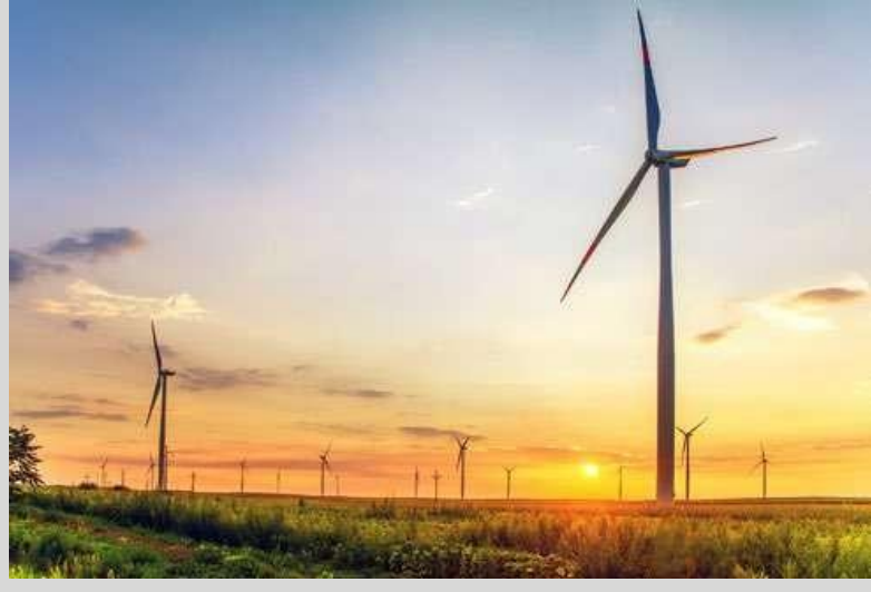
Parque Eólico Progreso
