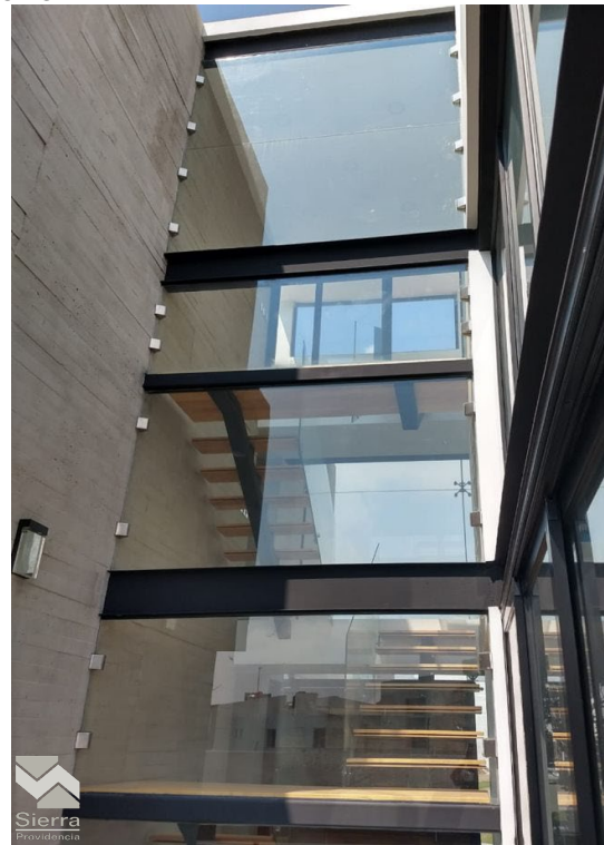
ESCALERAS/ VISTA DESDE EXTERIOR
