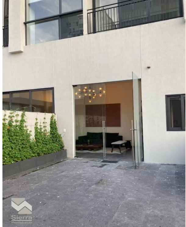
INGRESO A LA TORRE
