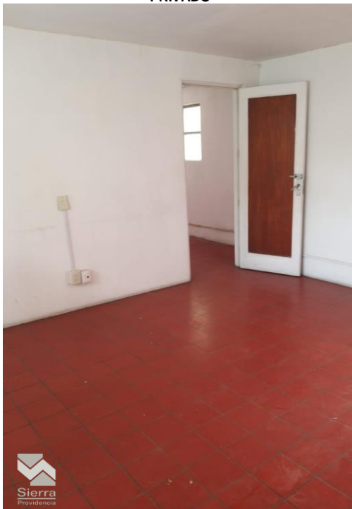
ÁREA SEGUNDO NIVEL
