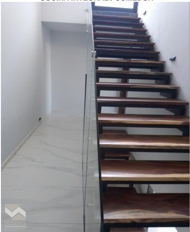
ESCALERAS AL SEGUNDO NIVEL
