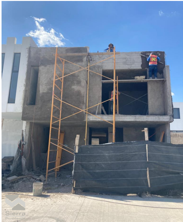
AVANCE DE OBRA
