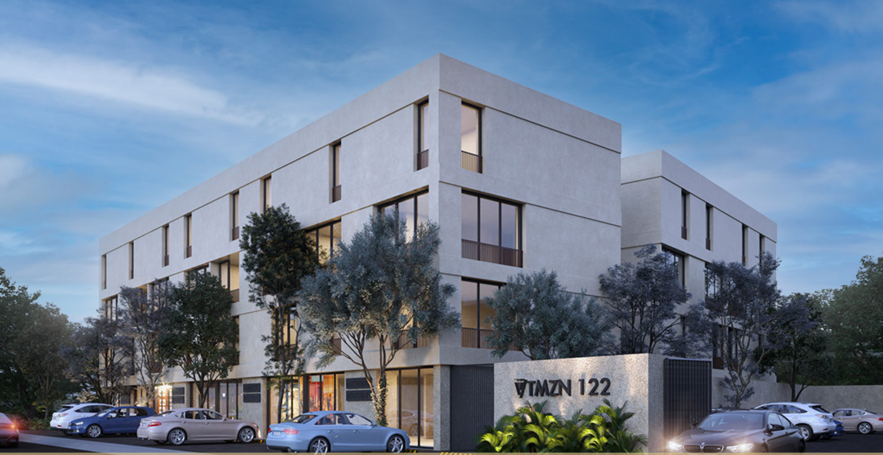
Fachada Posterior/Estacionamiento Privado
