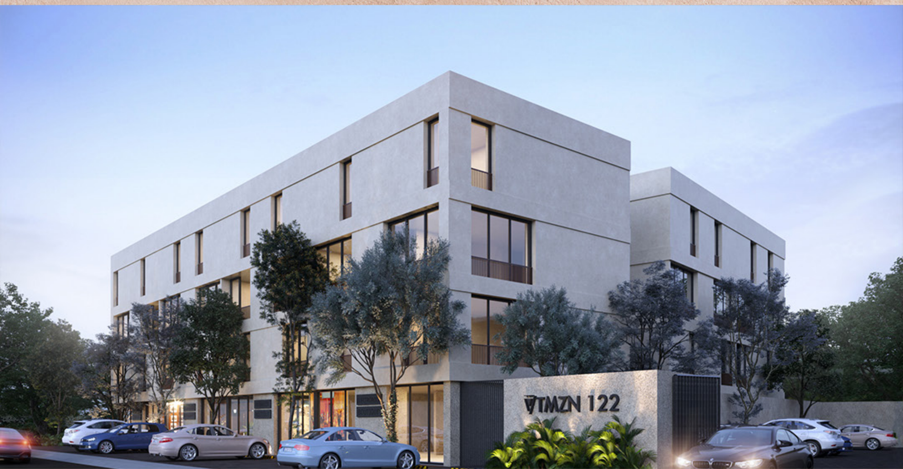
Fachada Posterior/Estacionamiento Privado
