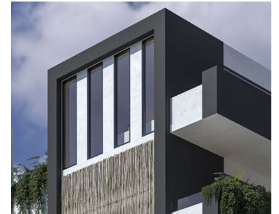
F Pintura negra en fachada
