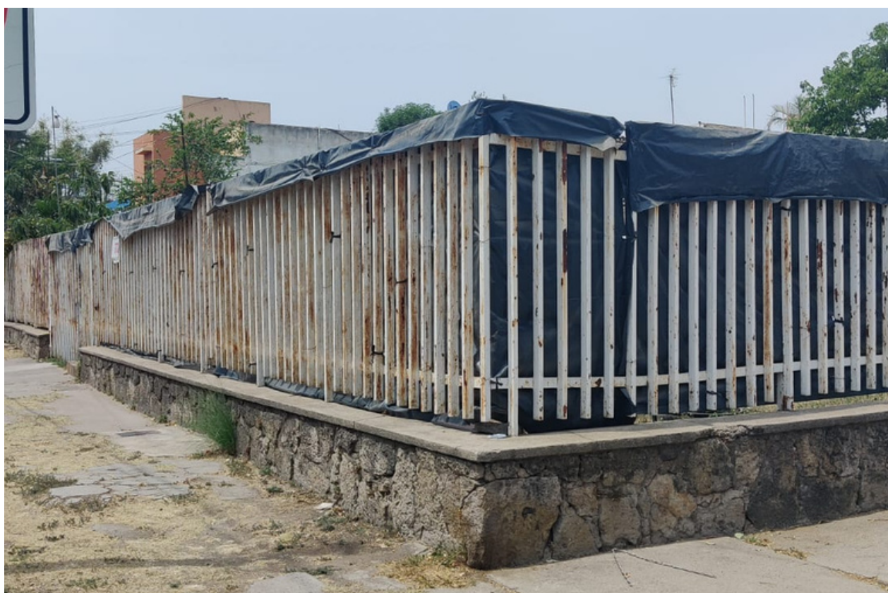
Vista a terreno desde la calle
