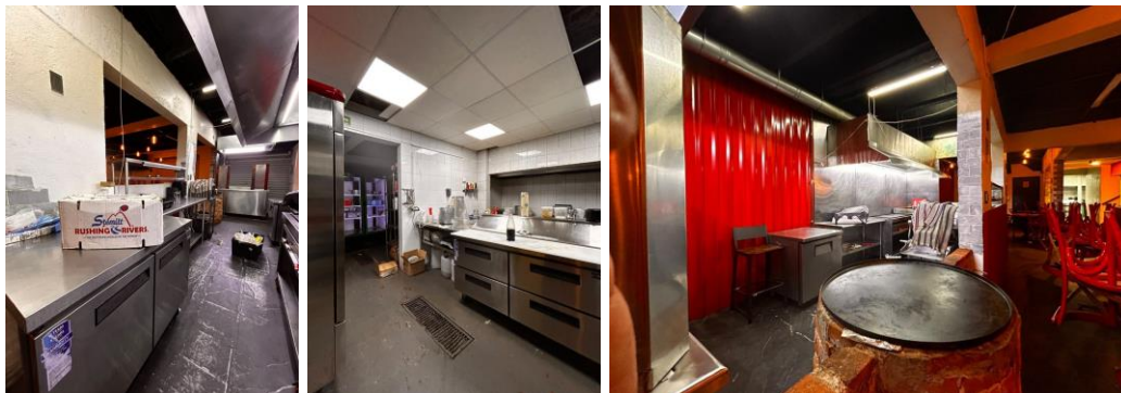
Cocina: mesas frías, refrigeración, extracción y comal
