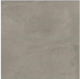
PATIO POSTERIOR Piso de concreto aparente.
