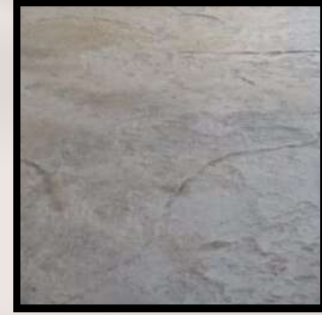
2.PISO DE CEMENTO ESTAMPADO COLOR GRIS TIPO LAJA EN COCHERA.
