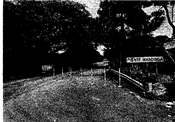
CARRETERA LITORAL FRENTE A ACCESOS E IDENTIFICACION DEL PUENTE MANDINGA
