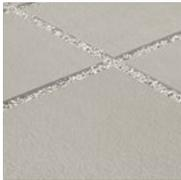
Placas de concreto gris martelinado, con sellador impermeable mate y juntas abiertas rellenas de gravilla blanca.
