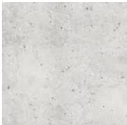
Calcreto conformado por mezcla de polvo, grava, cal y cemento para pendientes hacia los bajantes pluviales.
