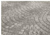
Pavimento de concreto hidráulico con terminado estampado de abanico.
