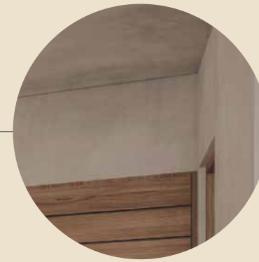
Paredes y techos de chukum
