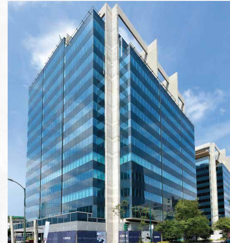
Oficinas Parques Plaza Nuevo Polanco CDMX
