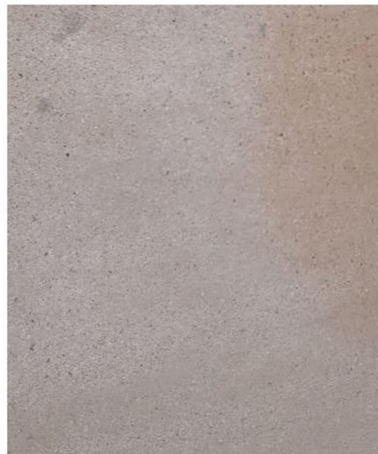
ACABADO DE CEMENTO BLANCO LAVADO, EN PISOS DE BALCON Y TERRAZA DE ROOF, CON AGREGADO FINO.
