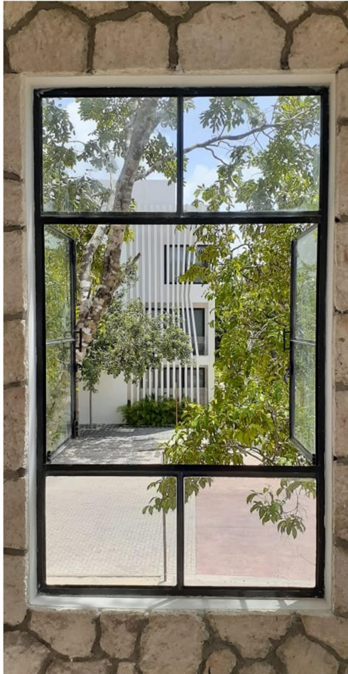
HERRERIA FORJADA A MANO CON CRISTAL DE 6MM EN VENTANAS Y CANCELES EXTERIORES ABATIBLES Y DE PROYECCION.
